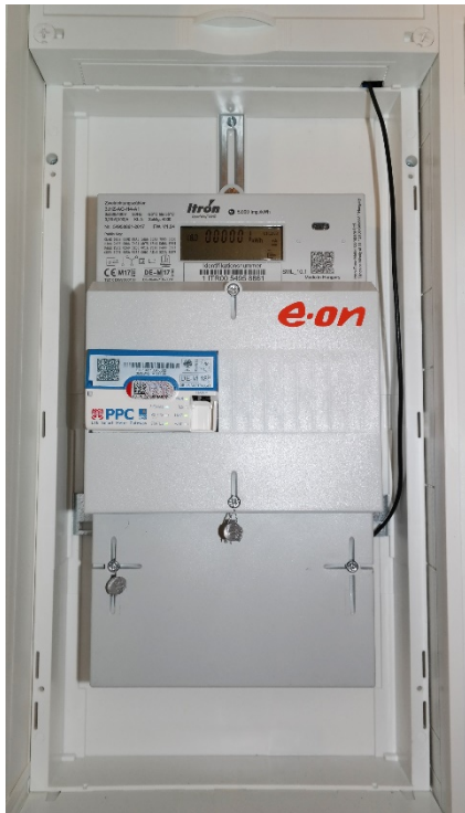
Abb. 3 Zertifiziertes Smart Meter Gateways im Betrieb
