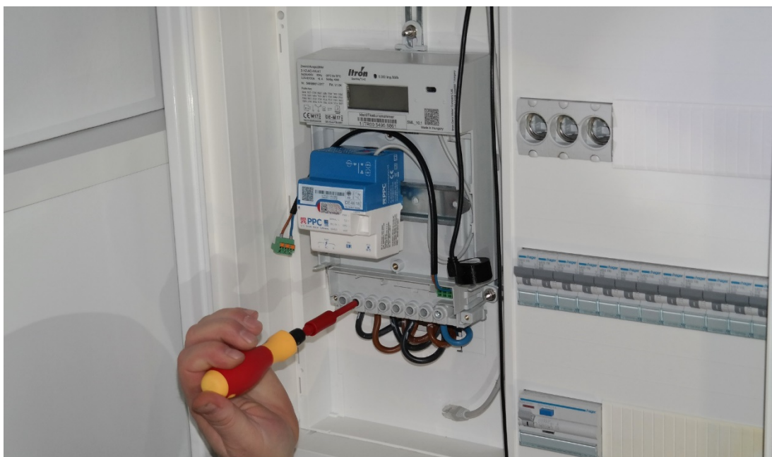
Abb. 2 Einbau des ersten zertifizierten Smart Meter Gateways
